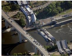
図3: 州間高速道路35w線の崩落事例
